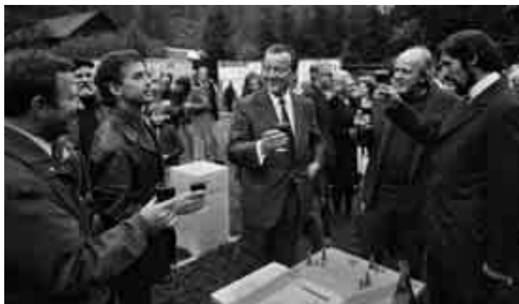
6. Günther Kraus, Landeshauptmann Hans Sima (Mitte), Otto Eder und Hans Muhr bei der Grundsteinlegung 1973
